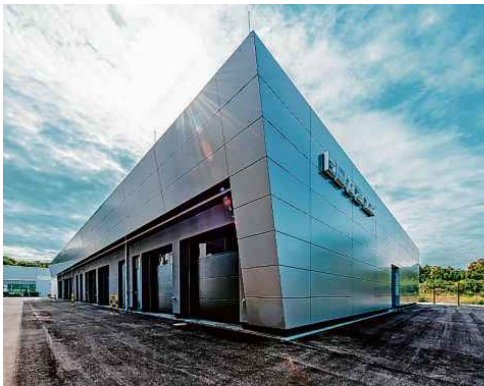
Das Hochvolt-Batterieprüfzentrum in Ehningen.
